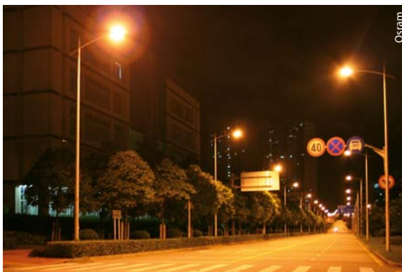
Abb. 2 Die herkömmliche 250-W-Natriumdampflampe (links) verbraucht mehr als doppelt so viel Energie wie die 108-W-LED-Strassenleuchte (rechts).
