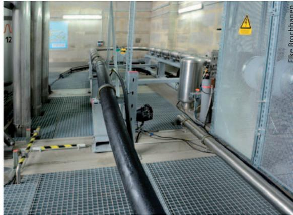
Das weltweit längste Supraleiterkabel wurde offiziell in das Essener Stromnetz integriert und verbindet für den Testbetrieb zwei Umspannanlagen.
