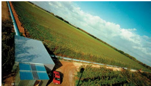
Abb. 11: Blick auf den Gravitationswellendetektor GEO600 mit den beiden Interferometerarmen und dem Haus mit Strahlteiler und Laser. (Foto: MPI für Gravitationsphysik und U Hannover)
