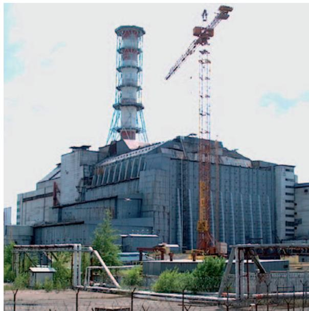
**Abb. 6:** Nach dem Unfall wurde der Reaktorblock 4 mit einem Betonmantel („Sarkophag“) eingehüllt. (Quelle: ZSR, Universität Hannover)
