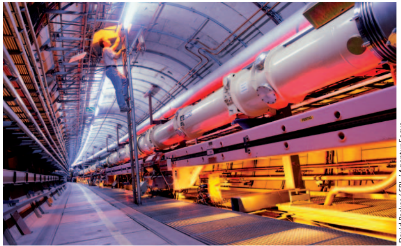
Der HERA-Tunnel enthält sowohl einen supraleitenden als auch einen konventionellen Beschleuniger für Protonen bzw. Elektronen.
