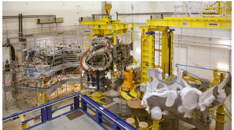
In der Experimenthalle des IPP in Greifswald wird das Fusionsexperiment Wendelstein 7-X aufgebaut. Links sind zwei der fünf Module zu sehen. Eines davon steht auf der Experimentierplattform, auf der sich rechts ein Teil des Außengefäßes befindet.
