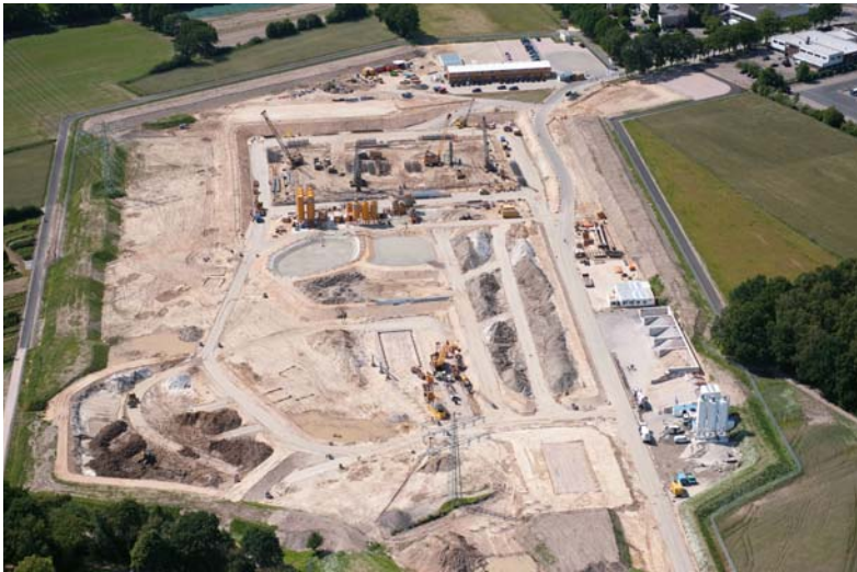
Im Süden der Stadt Schenefeld entstehen u. a. die XFEL-Experimentierhalle und das Hauptgebäude.
